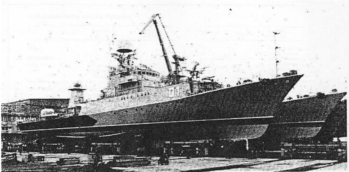
Die ersten Einheiten des Projektes 133.1 M im Bau auf der Peenewerft Wolgast
