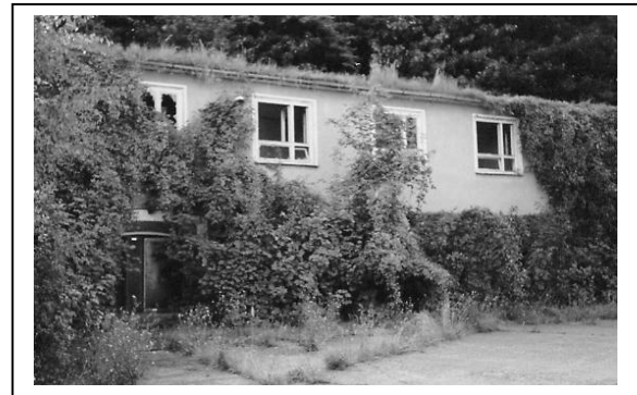
Ruine des Stabsgebäudes der 3. KSSA Quelle: Verfasser
